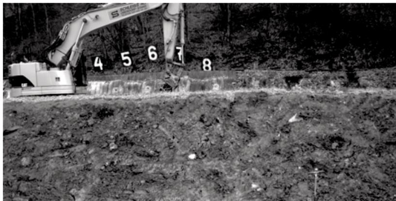
Die Altlasten beim Schiessstand Riedboden wurden Schritt für Schritt abgetragen
