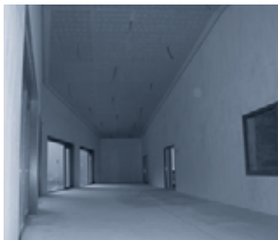
Gelochte Gipskartondecke Foyer Aula
