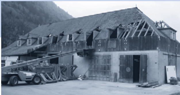
Der Abbruch des Daches und der Holzkonstruktion
