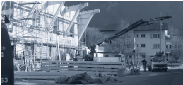
Die Holzkonstruktion wurde gleich vor Ort zusammengebaut
