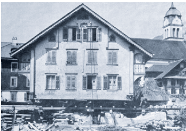
Über den spektakulären «Umzug» des Pfarrhauses wurde schweizweit berichtet
