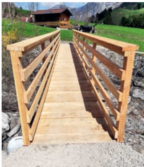
Die fertig erstellte Brücke
