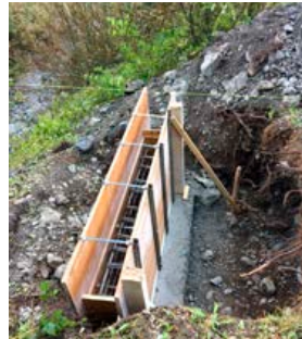
Brückendfundament
