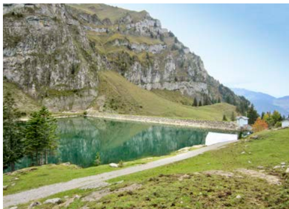
Staudamm in Richtung Stäubi
