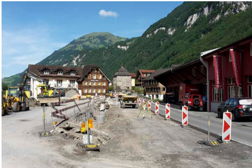
Umbau Parkplatz Ochsen
